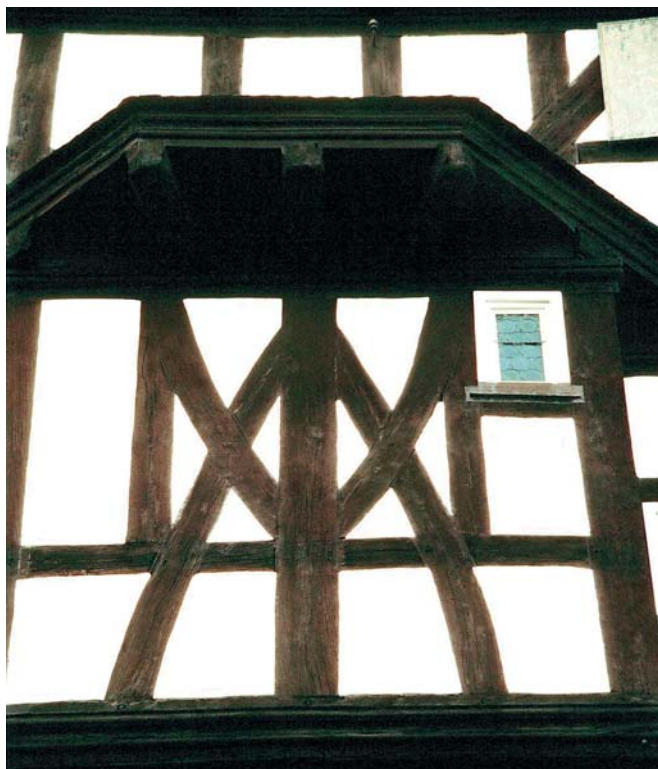
Abb. 4: Neben den „Alsfelder Streben“ benutzte Zimmermeister Johann auch die zu dieser Zeit im mittleren Deutschland übliche Strebenform des „Wilden Mannes“ mit überkreuzten geschweiften Fuß- und Kopfstreben.
