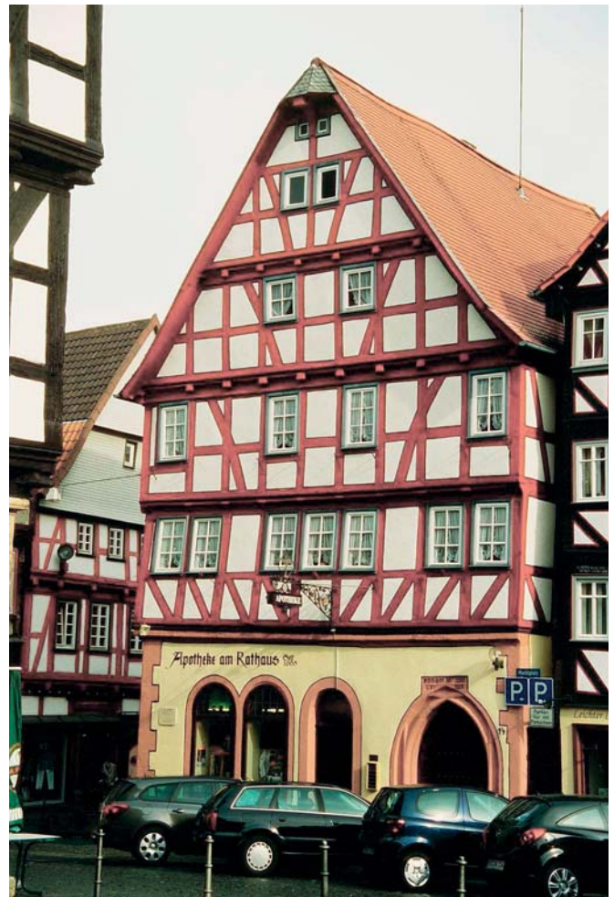
Abb. 6 und 7: In Alsfeld kommt die Alsfelder Strebe nach dem Rathaus öfter vor, wie in drei Stockwerken übereinander am Haus Amtshof 13, etwa 1520 errichtet und der 1561 errichteten Apotheke Markt 14.
