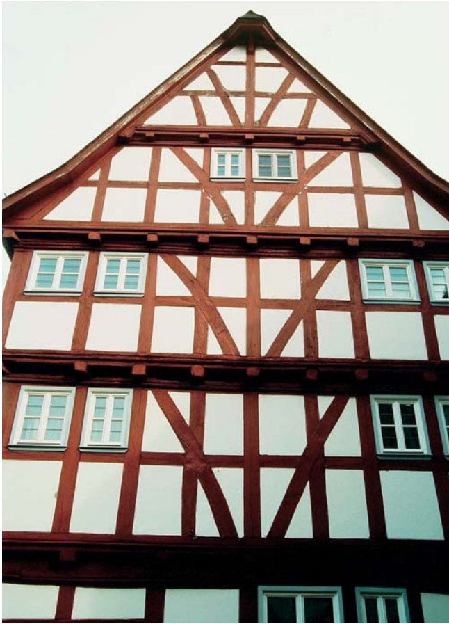
Abb. 6 und 7: In Alsfeld kommt die Alsfelder Strebe nach dem Rathaus öfter vor, wie in drei Stockwerken übereinander am Haus Amtshof 13, etwa 1520 errichtet und der 1561 errichteten Apotheke Markt 14.
